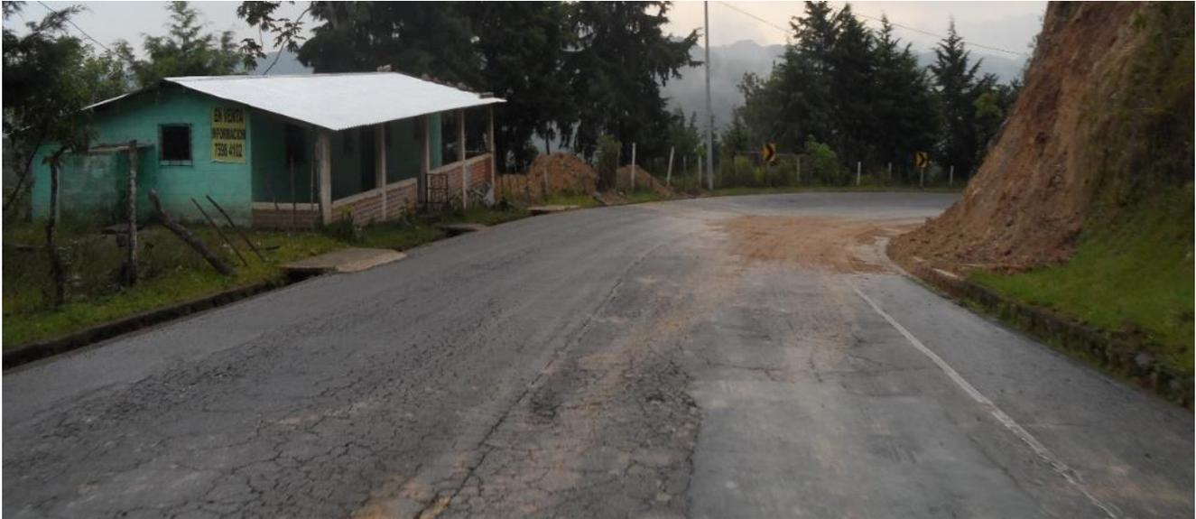
Figura 42. Daños en carreteras asfaltadas que impiden la circulación segura para el turismo.
